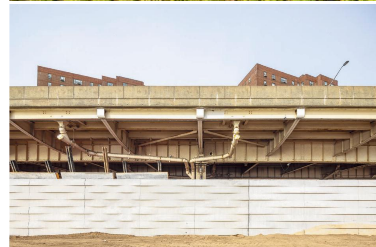
Werkzaamheden aan een waterkering in New York, de East Side Coastal Resiliency, naar het ontwerp van het Nederlandse bureau One Architecture.
