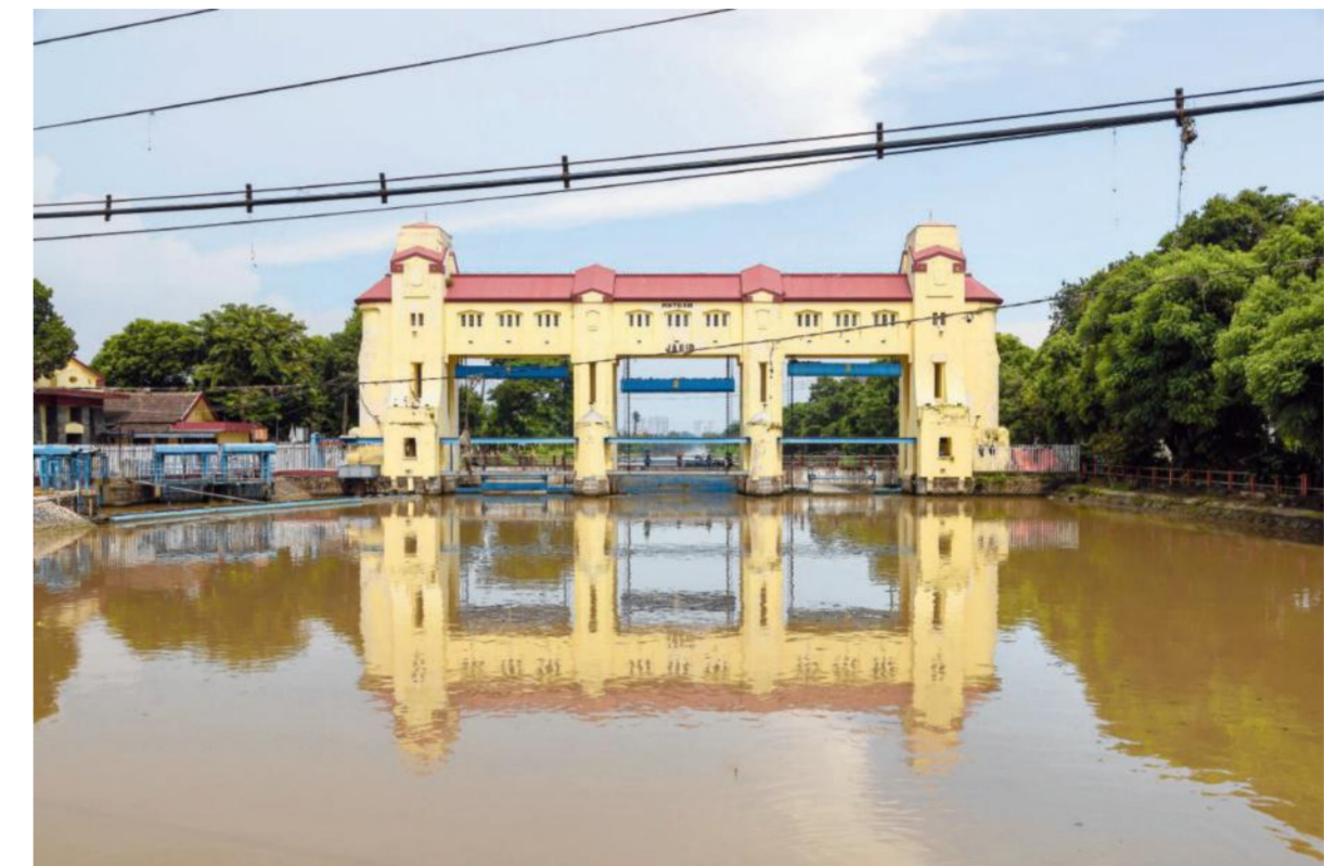
Het stuwcomplex Jagir in de Indonesische stad Soerabaja.
